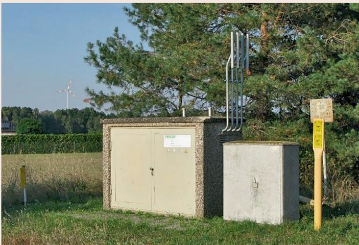
**Bild 2.13:** Gasdruckregelanlage Schopisdorf mit einer von zahlreichen Windkraftanlagen in der Region Fläming, Quelle: DVGW-EBI
