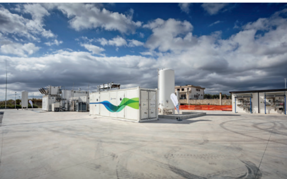
Abb. 3: Die Demoanlage im italienischen Troia kombiniert einen neuartigen Mikroreaktor für die Methanisierung mit einer innovativen Verflüssigungsanlage; das erforderliche \text{CO}_2 wird aus der Umgebungsluft gewonnen.
