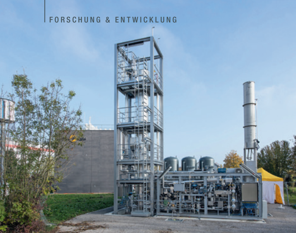
Abb. 2: Als einziger der drei Standorte kommt in der Anlage in Solothurn (Schweiz) die biologische Methanisierung zum Einsatz, bei der Mikroorganismen \text{CO}_2 und \text{H}_2 zu Methan umsetzen.
