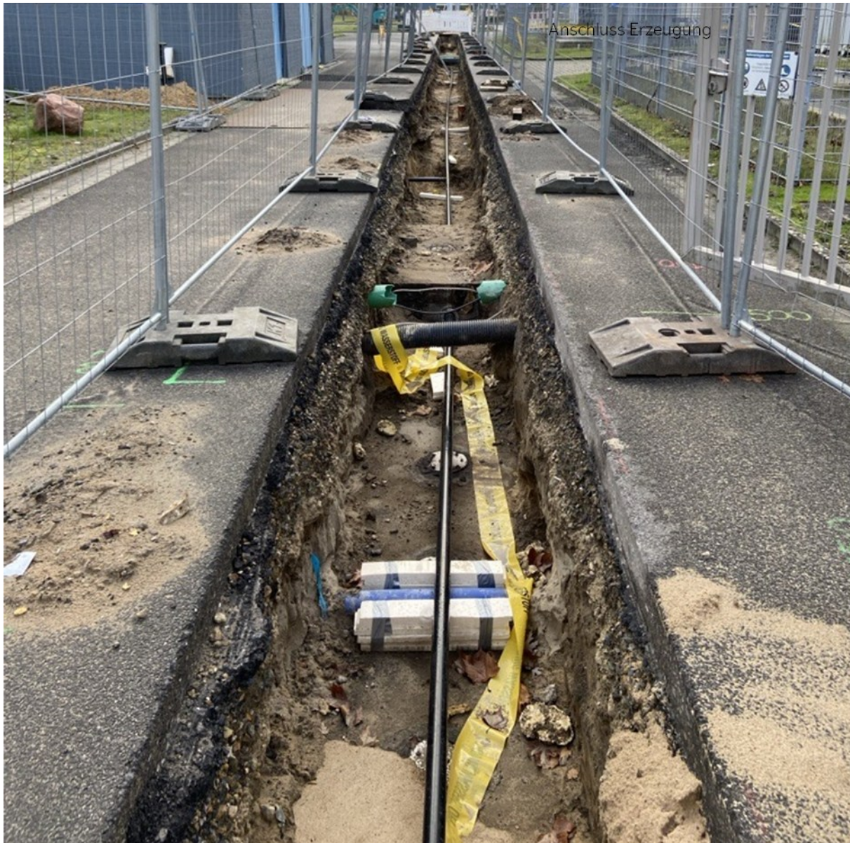
Abbildung III.2.2: Unterirdische Anschlussleitung zur Anbindung der H 2 -Erzeugungsanlage an die Versuchspipeline während der Bauzeit
