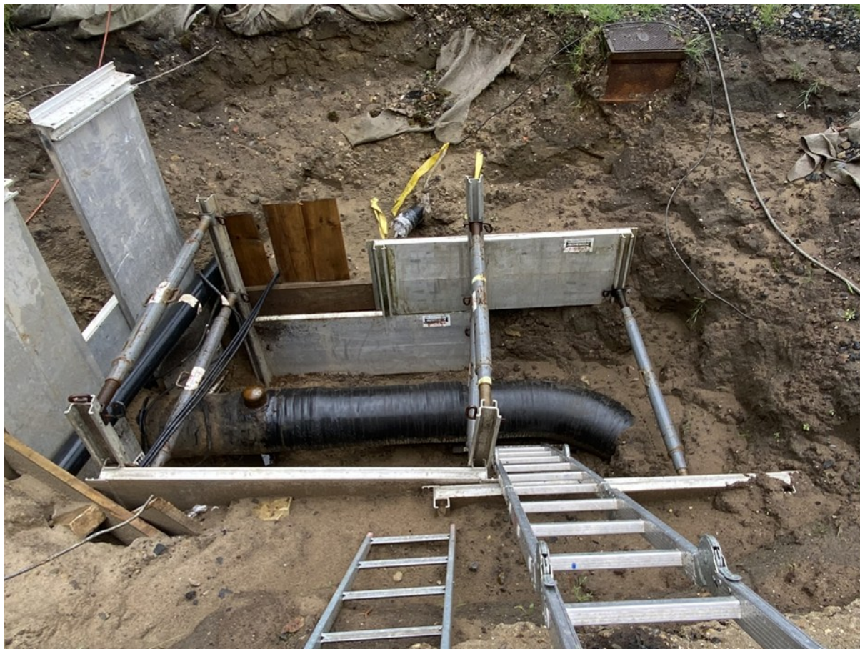
Abbildung III.2.3: Wandstärkenmessung an Rohrleitung des Testloops
