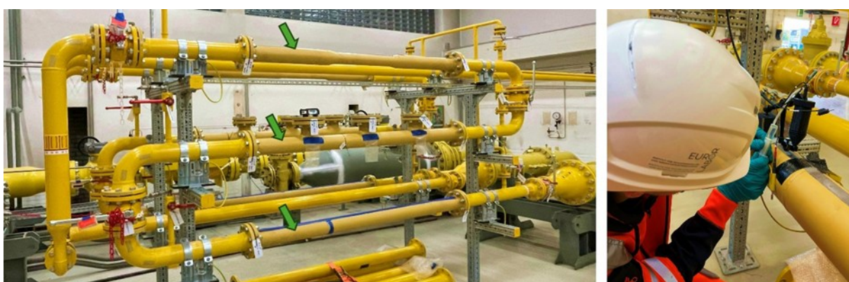
Abbildung IV.4.5: Links - eingebaute Teststrecken nach erfolgreicher Dichtheitsprüfung durch den TÜV Nord; rechts - erste in-situ Wasserstoffmessungen an den montierten Teststrecken durch Ruhr-Universität Bochum / Euro-Labor GmbH
