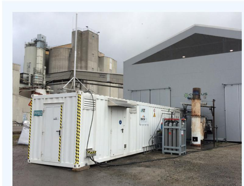
**Bild 1.13:** Einsatz der Demonstrationsanlage zur Wabenmethanisierung in Kopplung mit der Biomassevergasung des schwedischen Partners Cortus Energy AB
