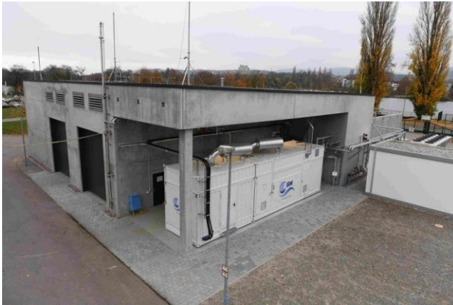
Der Forschungselektrolyseur des ZSW.
