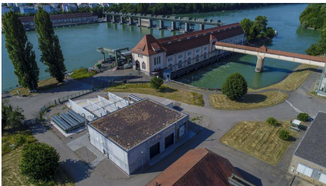
Die industrielle Power-to-Gas-Anlage am Wasserkraftwerk in Grenzach-Wyhlen.
